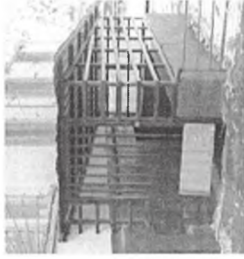
1. Подвалы жилых зданий
